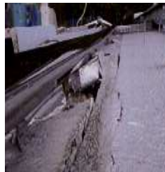
屋上から見た写真
