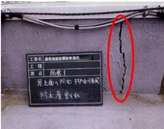
鉄塔がある屋上にできたひび割れ
