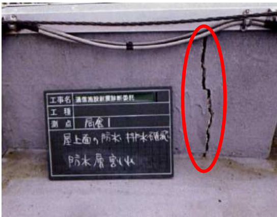
鉄塔がある屋上にできたひび割れ
