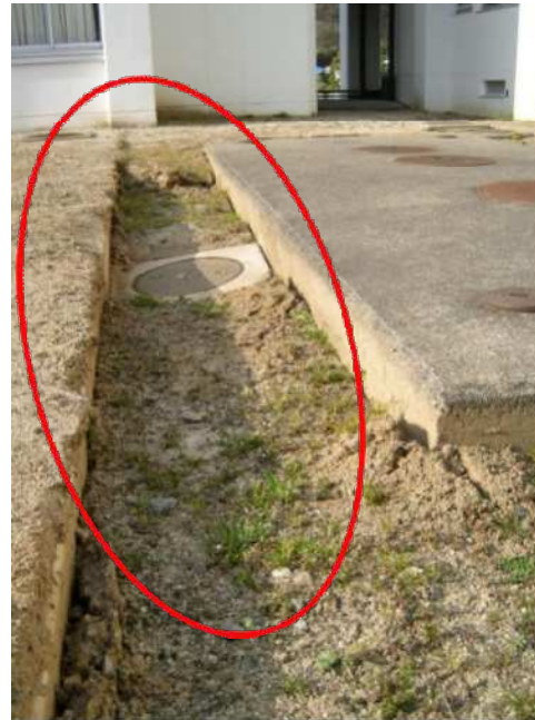
福島県警察学校 地盤沈下の状況
