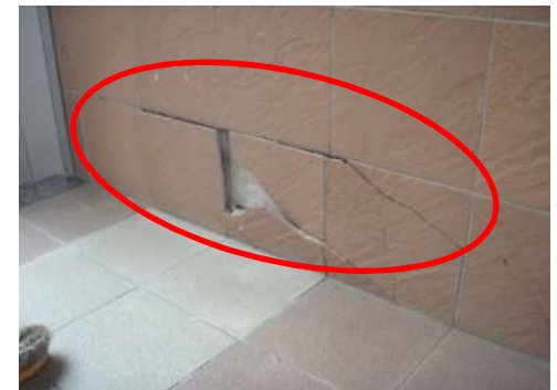
宮城県警察学校 壁崩落の状況
