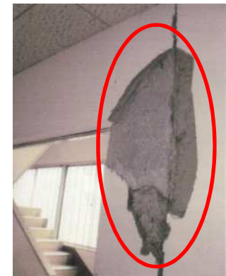
岩手県警察学校 壁崩落の状況
