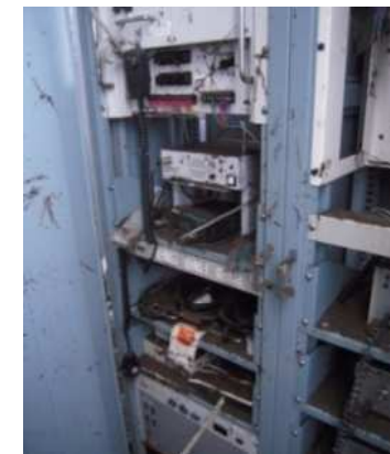
警察署の通信機械室において水没し、使用不能となった通信機器
