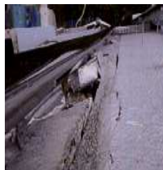
屋上から見た写真
