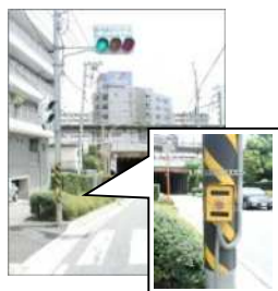
押ボタン式信号機の設置
