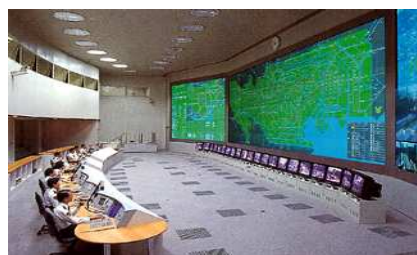
交通管制センター
