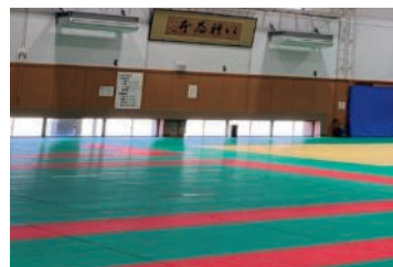
冷房設備を設置した道場
