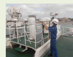
国境離島警備における 衛星電話アンテナの設置
