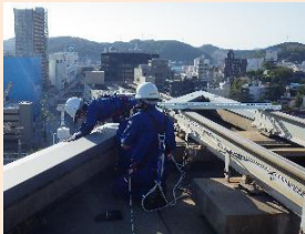
警護における 固定カメラの設置
