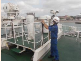
国境離島警備における 衛星電話アンテナの設置
