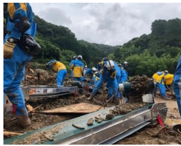
(R2.7豪雨災害) 土砂現場からの救助
