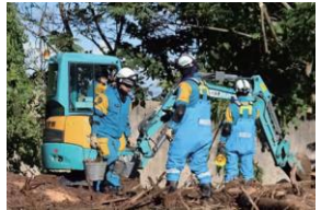
(R6.9.20からの大雨) 重機を活用した捜索
