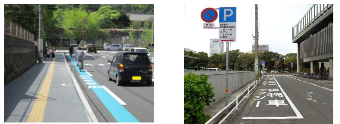
普通自転車専用通行帯の整備
