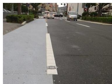
写真 II-6　規制標示「車両通行帯」を凹凸のある仕様とした事例
