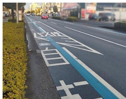
写真 II-13 バス停を示す路面表示を設置した事例
