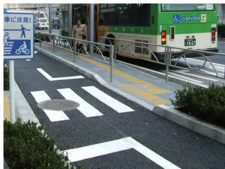
写真 II-5 停止線を設置した自転車道の事例
