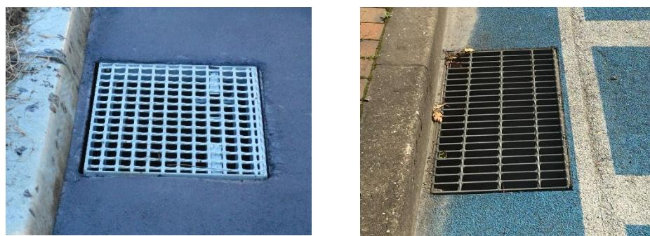
写真 II-3 グレーチング蓋の格子の形状等を工夫した事例
