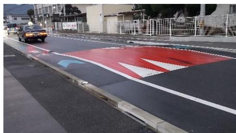
写真 II-10 車道部分にハンプを設置した事例
