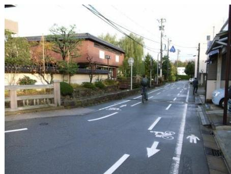
写真 II-9 自転車、歩行者双方の通行空間をピクトグラムにより明確化した事例
