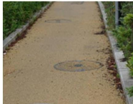
写真 II-4 マンホールの蓋に滑り止め加工した事例
