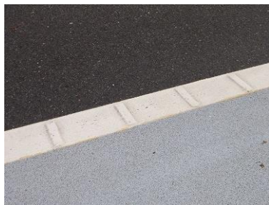
写真Ⅱ-6 道路標示「車両通行帯」を凹凸のある仕様とした事例
