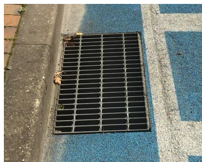
写真Ⅱ-3 グレーチング蓋の格子の形状等を工夫した事例
