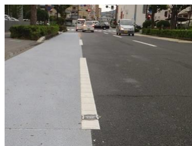
写真Ⅱ-6 道路標示「車両通行帯」を凹凸のある仕様とした事例
