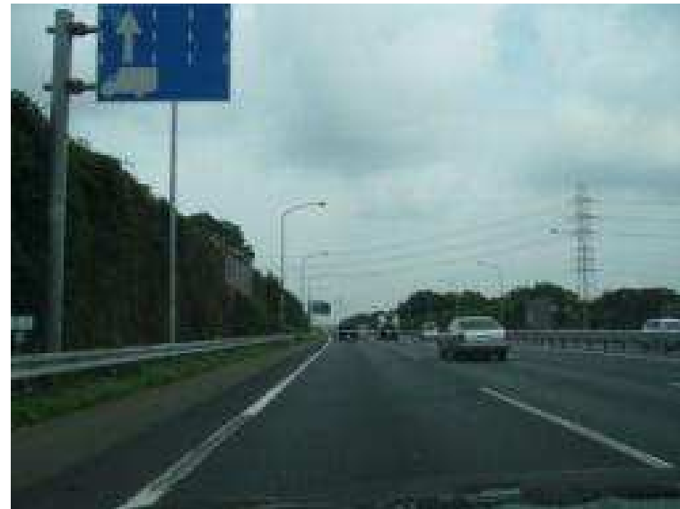
(例) 関越自動車道
