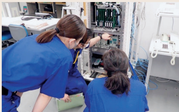
実機を用いた通信システム実習
