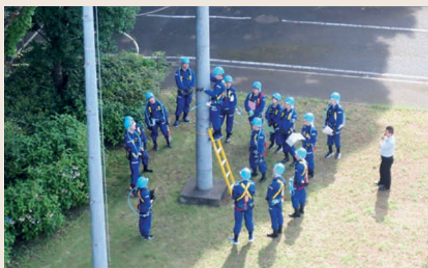
模擬無線鉄塔上での高所作業実習
