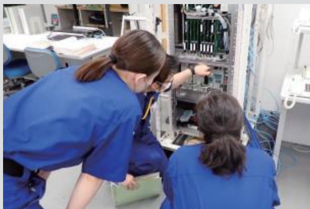
実機を用いた通信システム実習
