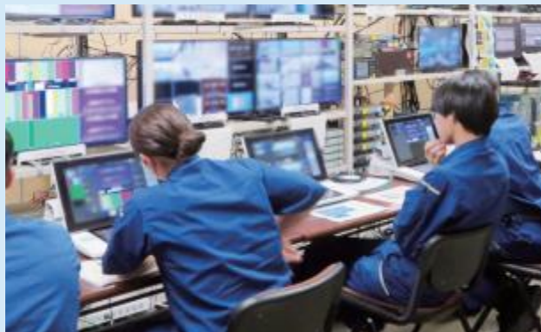
通信対策室の運用
