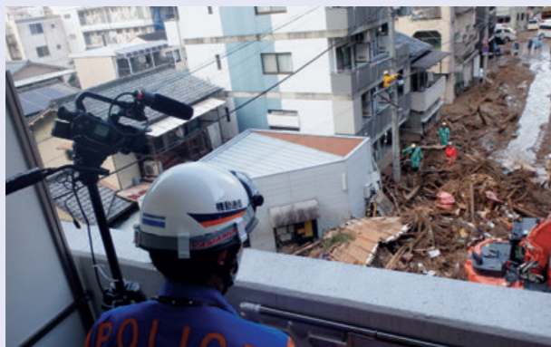
大雨における被災状況の映像撮影・伝送
