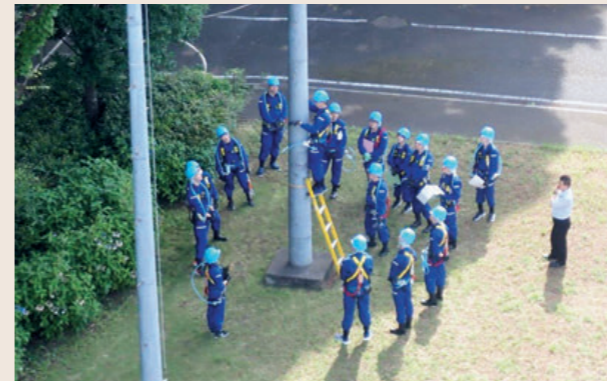
模擬無線鉄塔上での高所作業実習
