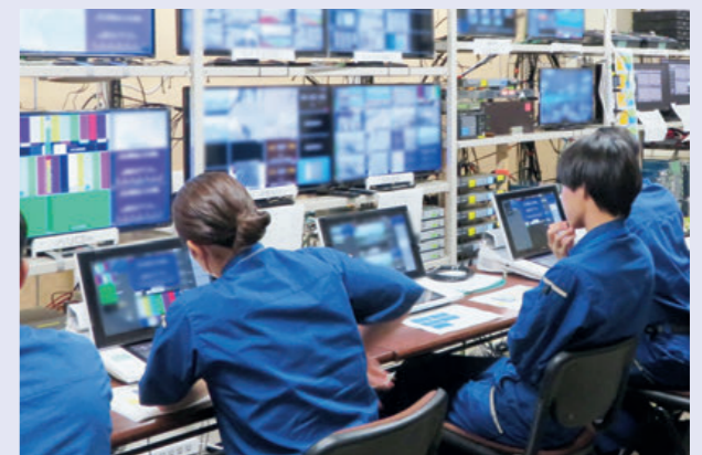
通信対策室の運用
