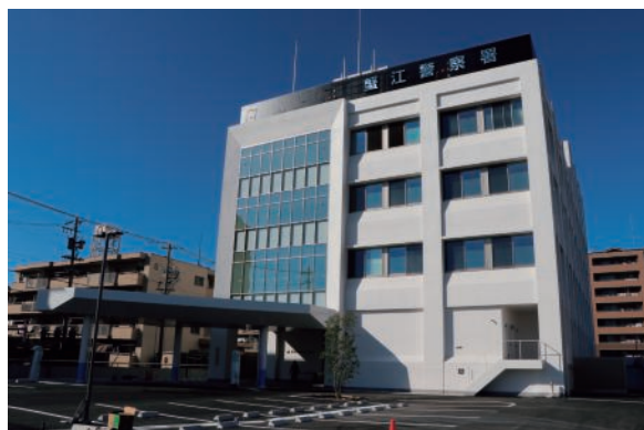
周辺道路より高い床面と2階以上の執務スペース
