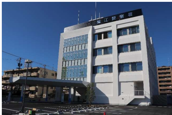
周辺道路より高い床面と２階以上の執務スペース
