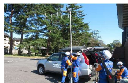
臨時無線中継所の設置状況
