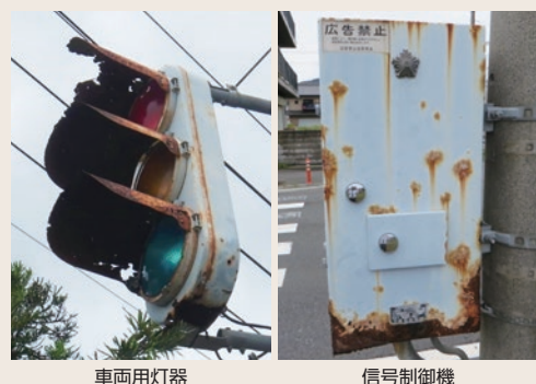
図表5-28 老朽化した交通安全施設
