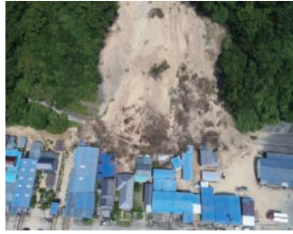
土砂崩れの状況
