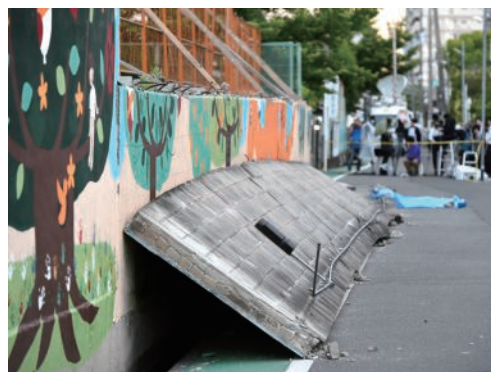
地震により崩壊したブロック塀（朝日新聞社）
