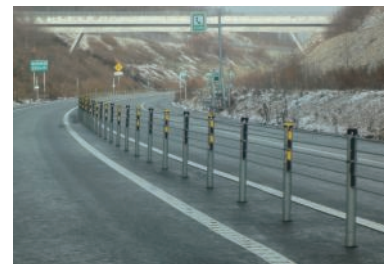
ワイヤロープの設置例（北海道縦貫自動車道）
