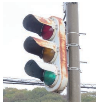
整備後長期間が経過した信号機
