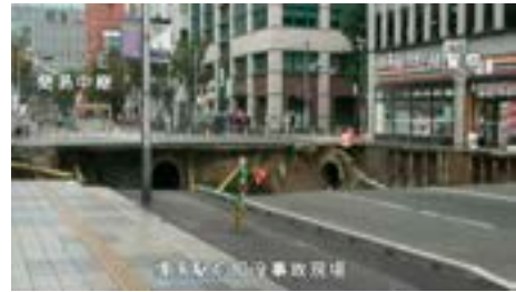
道路陥没事故の現場から伝送された映像
