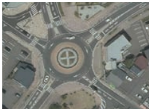
環状交差点（長野県飯田市）
