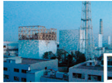
福島第一原子力発電所1号機 (東京電力株式会社)
