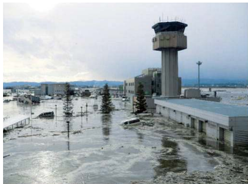
仙台空港の被災状況
