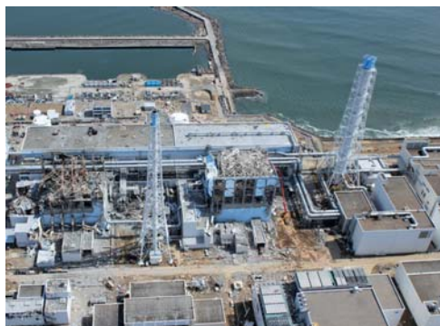
福島第一原子力発電所((時事)エアフォートサービス提供)
