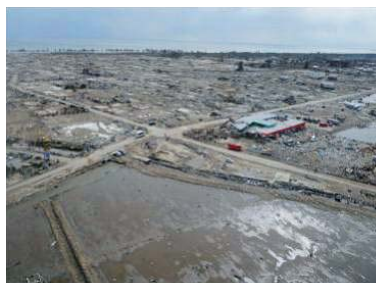
宮城県仙台市若林区荒浜地区の被災状況
