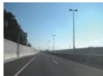
自動車の通行機能を重視した構造の道路 (栃木県宇都宮市 宇都宮北道路)
