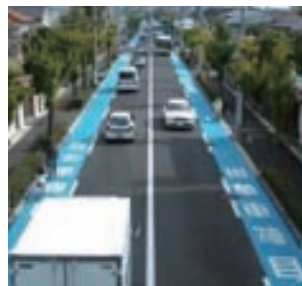
自転車専用通行帯の設置例 (兵庫県尼崎市)
