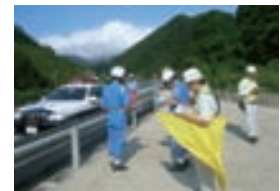
共同現地点検の状況
