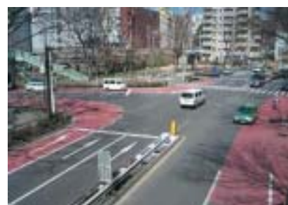
カラー舗装による 駐停車禁止区域の明示
