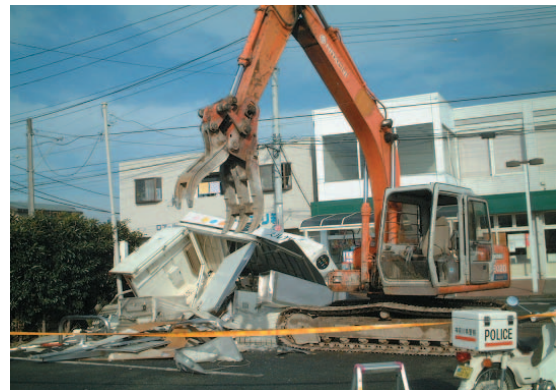
破壊されたATMブース
