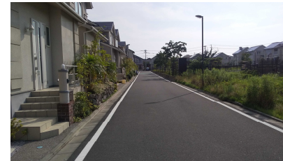
路側帯の設置された道路
