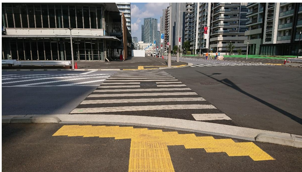
図 10 横断歩道接続部における視覚障がい者誘導用ブロックの設置状況 (写真②)
