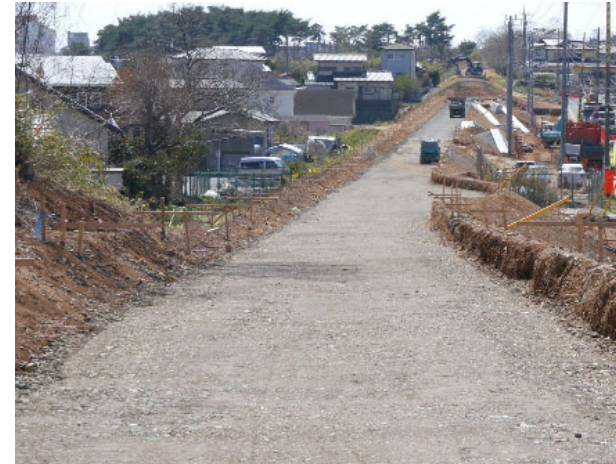
鉄道の廃線跡地に専用道路を敷設*1
