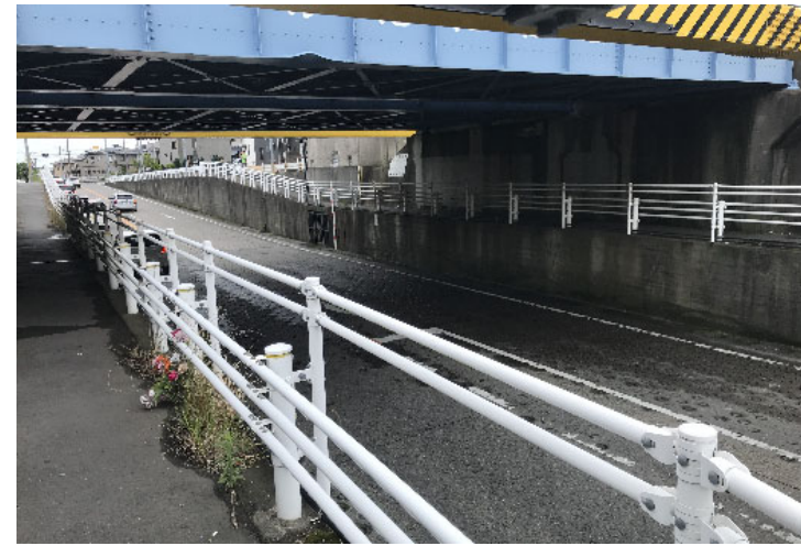
高架橋の下をくぐるアンダーパス
