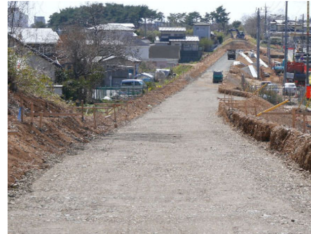
鉄道の廃線跡地に専用道路を敷設*1
