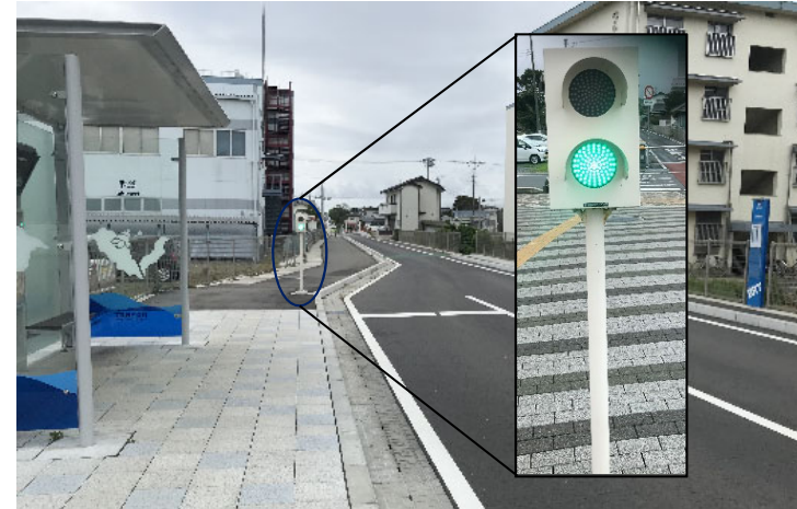
バス専用の管制信号
