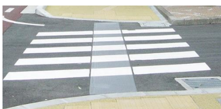
写真Ⅱ-12 横断歩道においてエスコートゾーンを設置した事例
