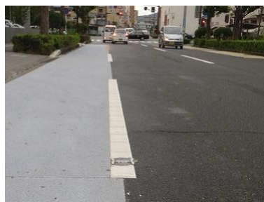
写真Ⅱ-6 規制標識「車両通行帯」を凹凸のある仕様とした事例
