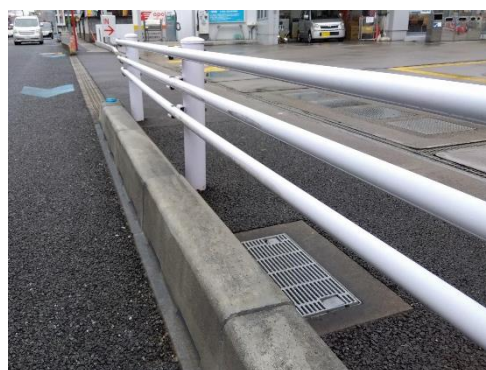
写真Ⅱ-2 歩道上の施設幅内に 集水ますを移設した事例
