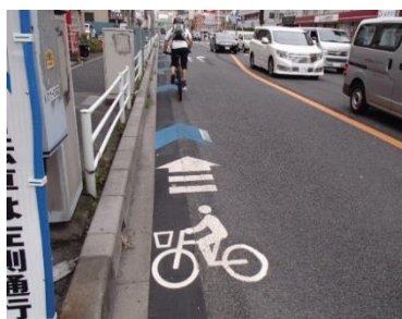
写真Ⅱ-7 矢羽根型路面表示等を設置した事例
