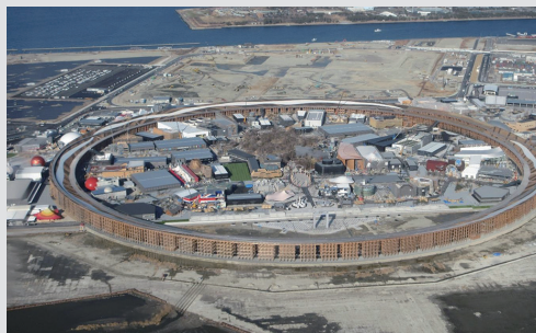
万博会場の建設状況 （大阪市夢洲：令和7年1月16日現在）
