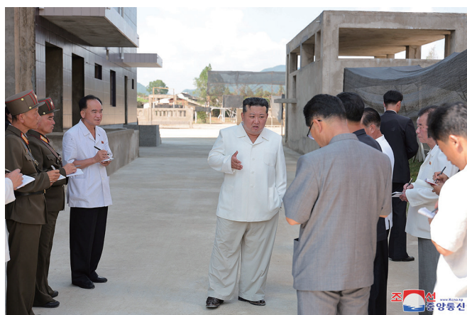
▲地方の工場建設現場を視察する 金正恩党総書記（朝鮮通信＝時事）
