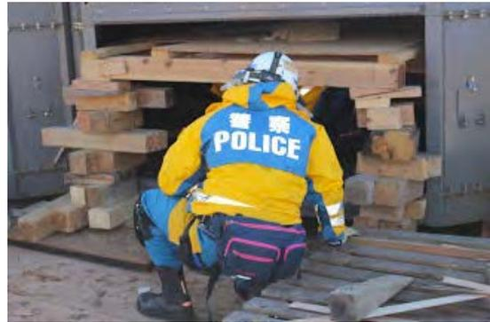
熊本地震後の訓練状況。瓦礫ハザードユニットを併用して現場周辺の状況も再現している。開口部への緊急補強の訓練なども調査分析結果の知見を活かし、行われている。
