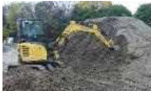
重機操作訓練ゾーン
