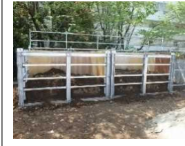
土砂埋没建物ユニット
