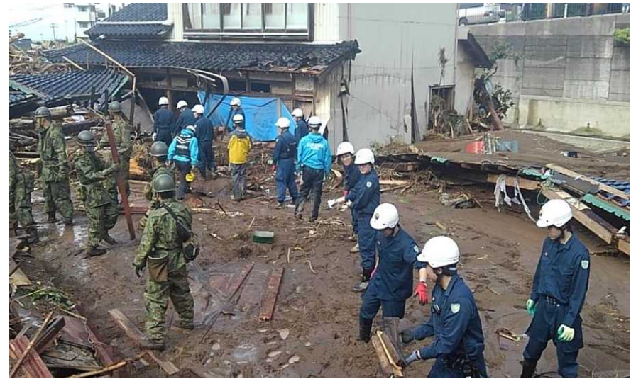
【石川県警察】家屋の倒壊現場における活動（輪島市内）
