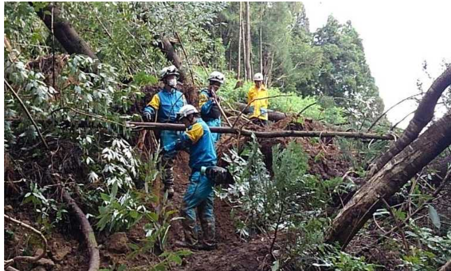
【石川県警察】土砂崩れが発生した道路上での活動 （輪島市内）
