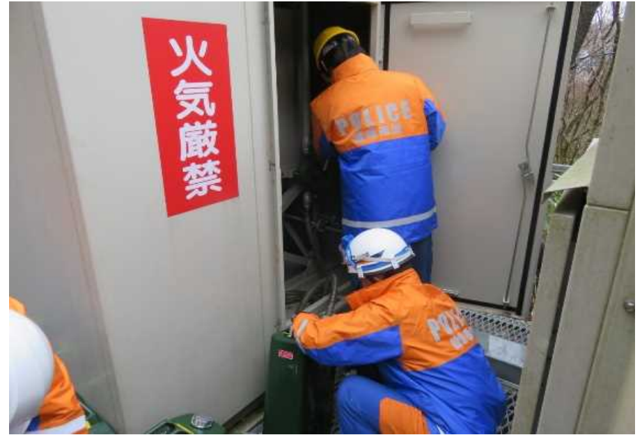
停電中の警察通信施設における機能維持作業
