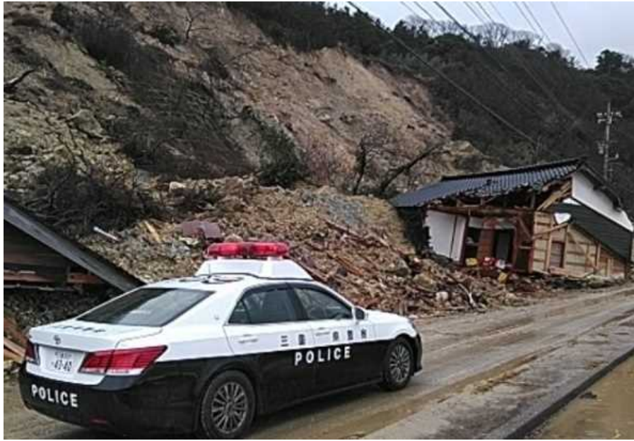
珠洲市におけるパトロール
