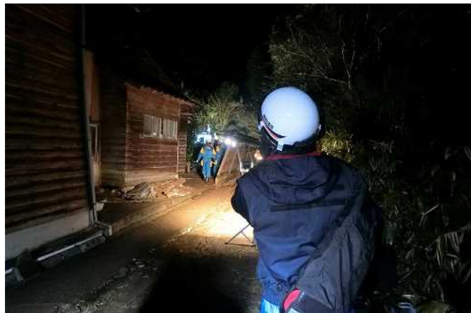
被災状況を把握するための撮影及び本部等への映像伝送
