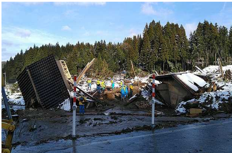
輪島市内における倒壊家屋の搜索
