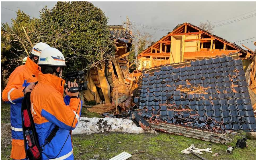
被災状況を把握するための撮影及び本部等への映像伝送
