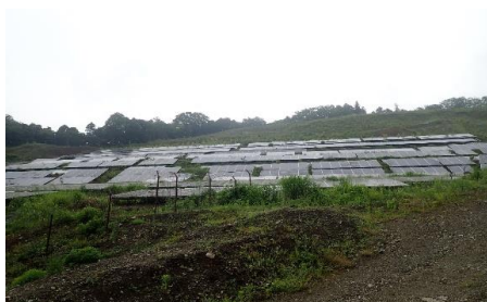
被害に遭った施設
