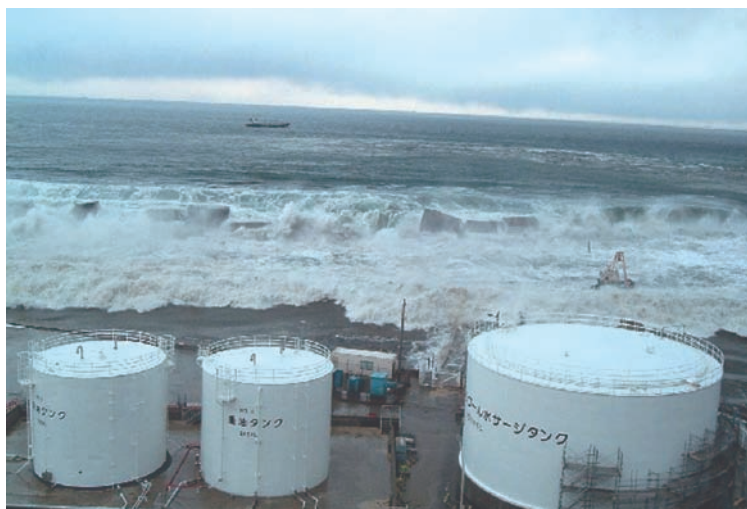
福島第一原子力発電所に押し寄せる津波 (東京電力株式会社)
