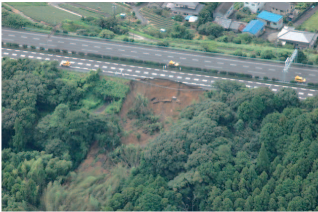
駿河湾を震源とする地震により崩落した東名高速道路牧之原サービスエリア付近の路肩（8月、静岡）
