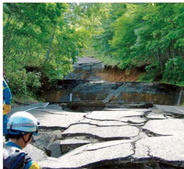
寸断された国道342号（岩手県一関市）
