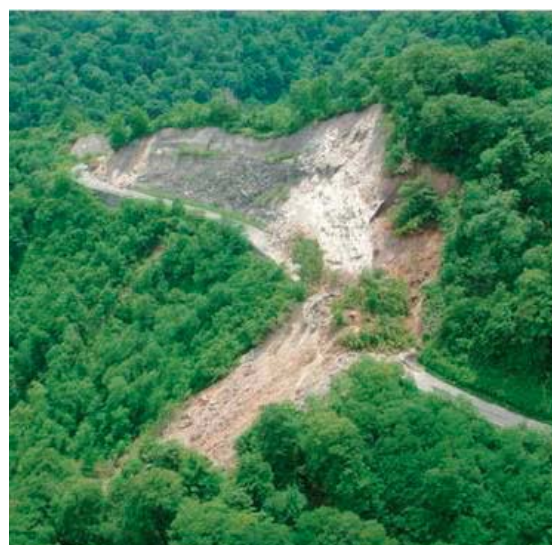
土砂崩れにより通行不能となった道路（宮城県栗原市）
