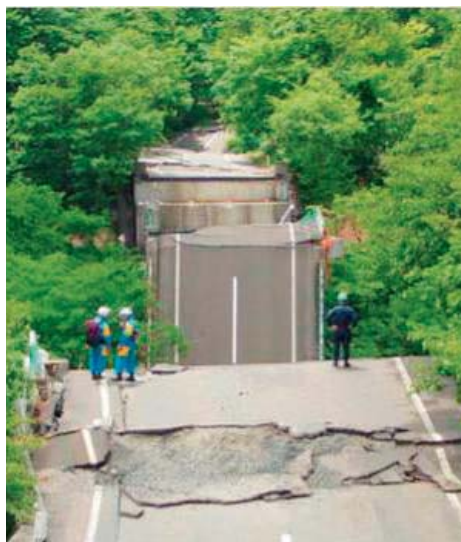
崩落した橋（岩手県一関市）
