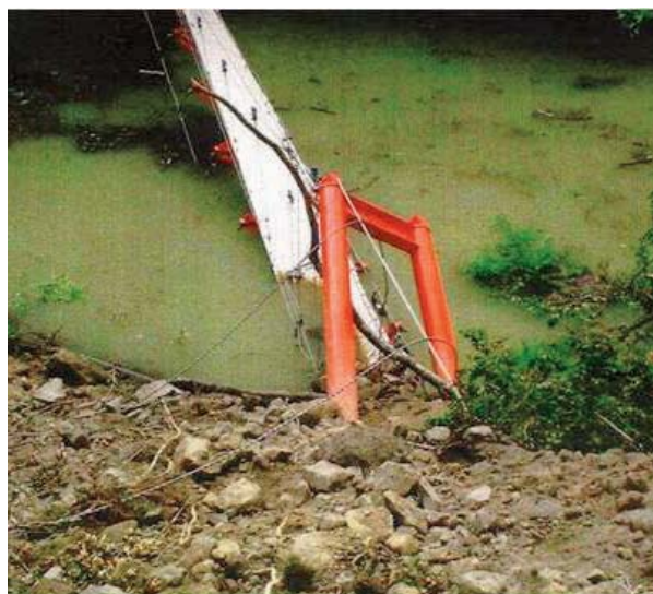
崩落した吊り橋（宮城県栗原市）
