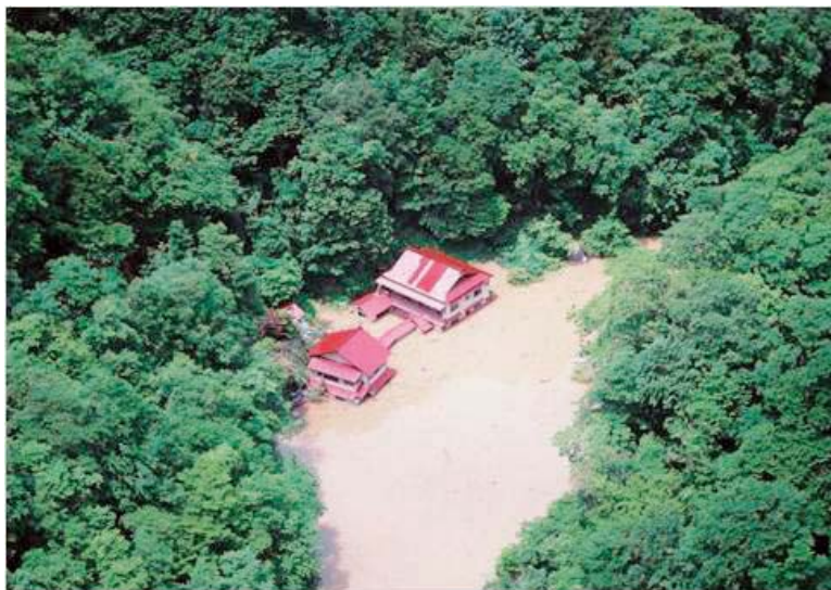
土砂崩れで沢がせき止められ浸水する温泉地（平成20年岩手・宮城内陸地震）
