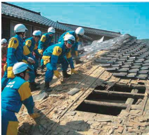
倒壊家屋での救出活動（石川県輪島市）
