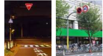
道路標識の高輝度化・大型化
