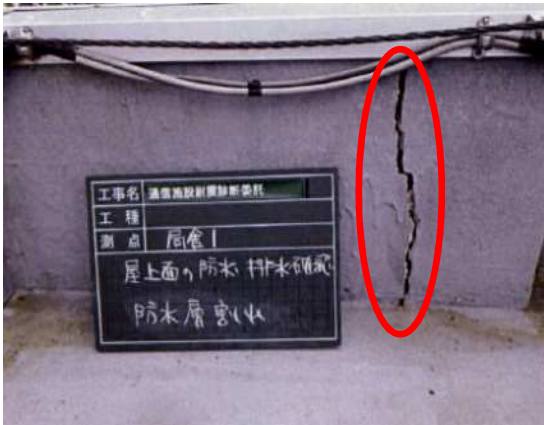
鉄塔がある屋上にできたひび割れ
