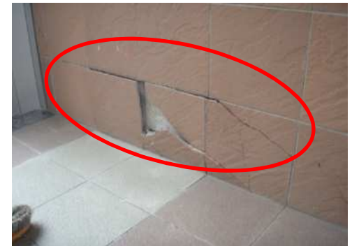
宮城県警察学校 壁崩落の状況
