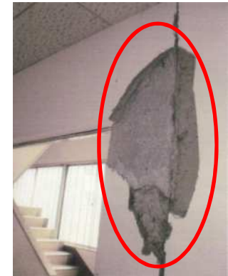
岩手県警察学校 壁崩落の状況
