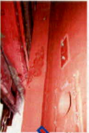
船底部外板の腐食
