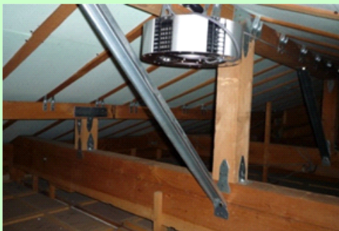
(悪質業者が施工した不要な屋根裏工事)
