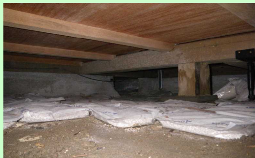
(床下に敷かれたマット)
